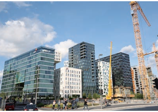
ビョルヴィカにつくられた12のアパートとオフィスビルから構成される バーコード・プロジェクト。敢えて、画一性をなくしたデザインで各建物は 設計された
