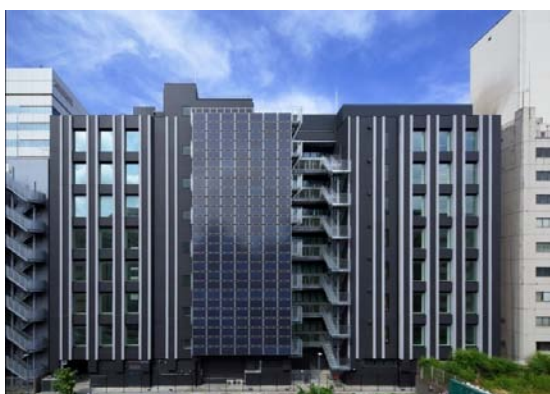
【外観（太陽光パネルの壁面設置）】
