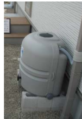
【雨水貯留タンク】
