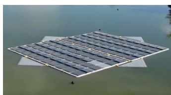
【池に浮かべた太陽光発電システム】
